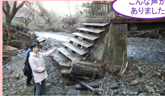
小仏川3号橋の様子
